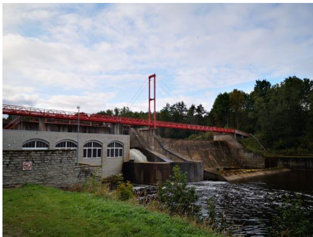
Photo 1. Linnamäe hydropower station (S. Oisalu)
