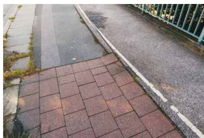
Joonis 71: Teekatte ebahütlane kvaliteet, Hamburg (Saksamaa) Allikas: Rudolph (2011)
