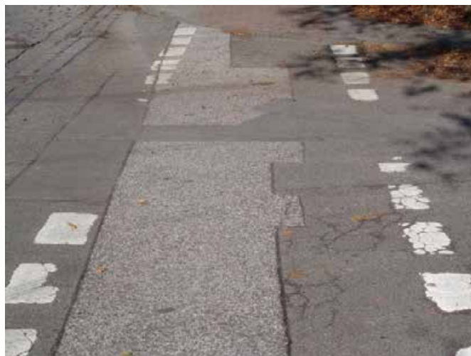
Joonis 62: Halvasti hooldatud teekate ja märgistused, Hamburg (Saksamaa) Allikas: Rudolph (2011)
