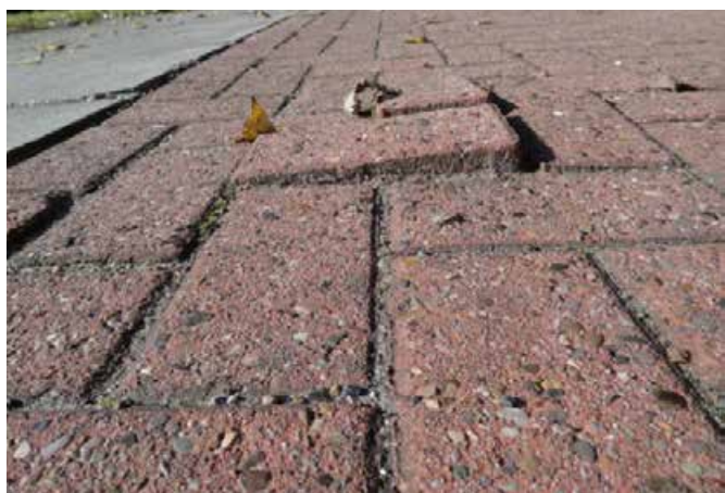
Joonis 54: Halvasti paigaldatud kivid, Hamburg (Saksamaa) Allikas: Rudolph (2011)
