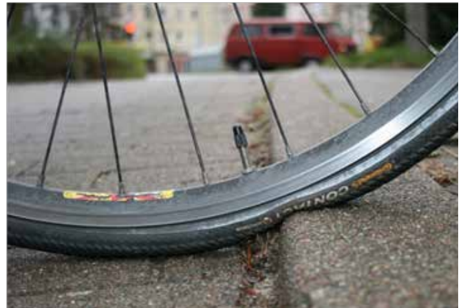
Joonis 60: Ümardatud betoonist äärekivi mõju rattale, Hamburg (Saksamaa) Allikas: Rudolph (2011)
