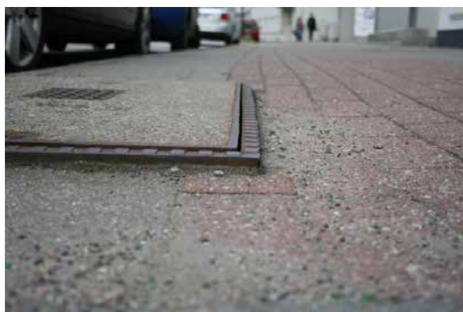
Joonis 70: Sillutisest 2,5 cm kõrgemal asuv luuk, Hamburg (Saksamaa) Allikas: Rudolph (2011)
