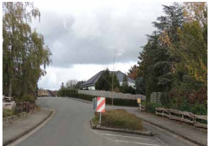
Joonis 42: Horisontaalne kitsendus, mis sunnib autosid teed andma ja millest jalgratas saab mööduda paremalt.
